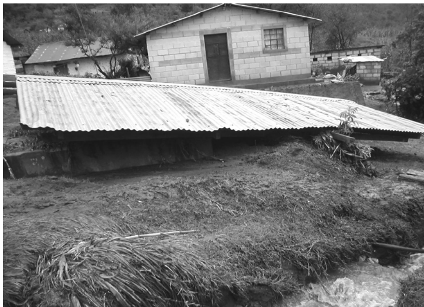
Fotografía 11 Municipio de San Juan Ostuncalco, Departamento de Quetzaltenango Vivienda destruida por tormenta Stan, aldea La Victoria Octubre 2005
