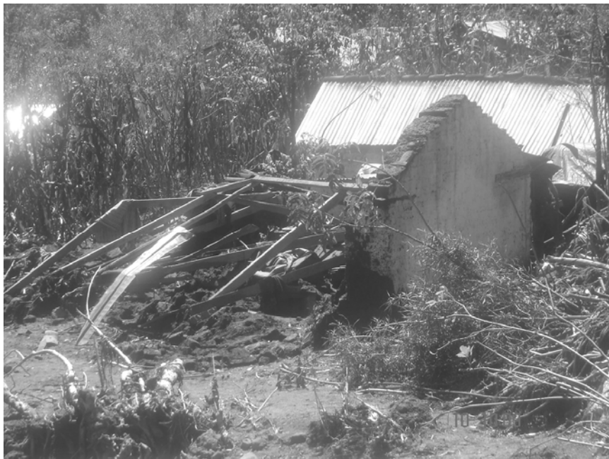
Fotografía 13 Municipio de San Juan Ostuncalco, Departamento de Quetzaltenango. Vivienda destruida por la tormenta Stan, caserío Los Pérez, aldea La Victoria Octubre, 2005
