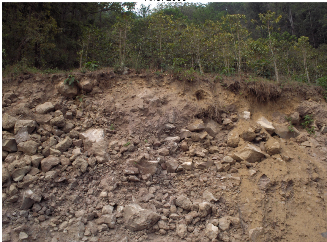
Foto 2 Municipio de San Pedro La Laguna - Sololá Fotos de Riesgos del Municipio Año: 2006
