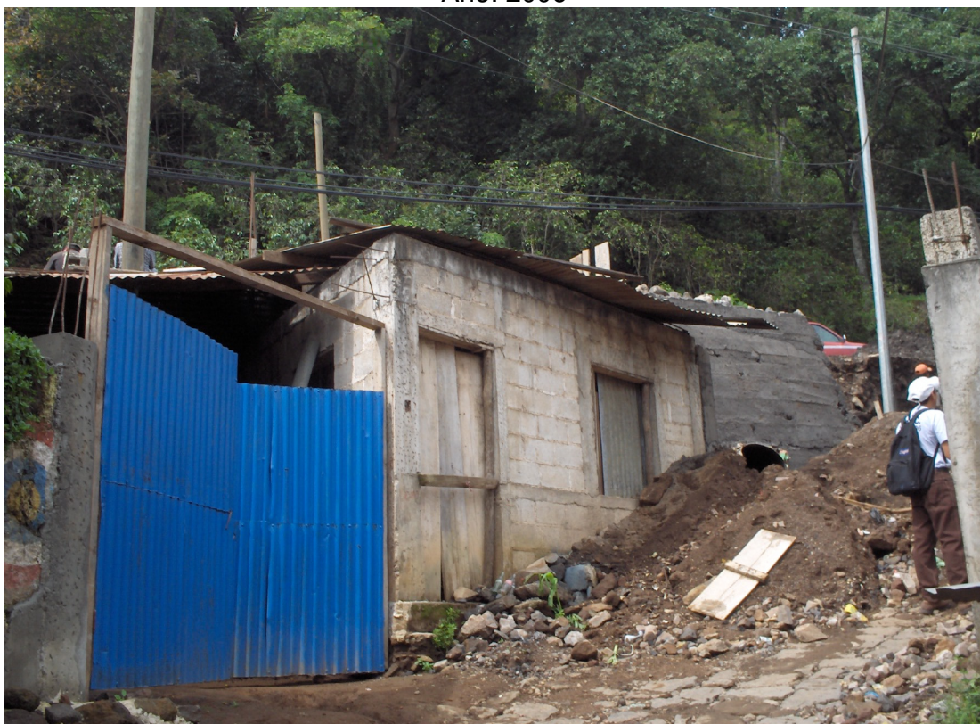
Foto 6 Municipio de San Pedro La Laguna - Sololá Fotos de Riesgos del Municipio Año: 2006
