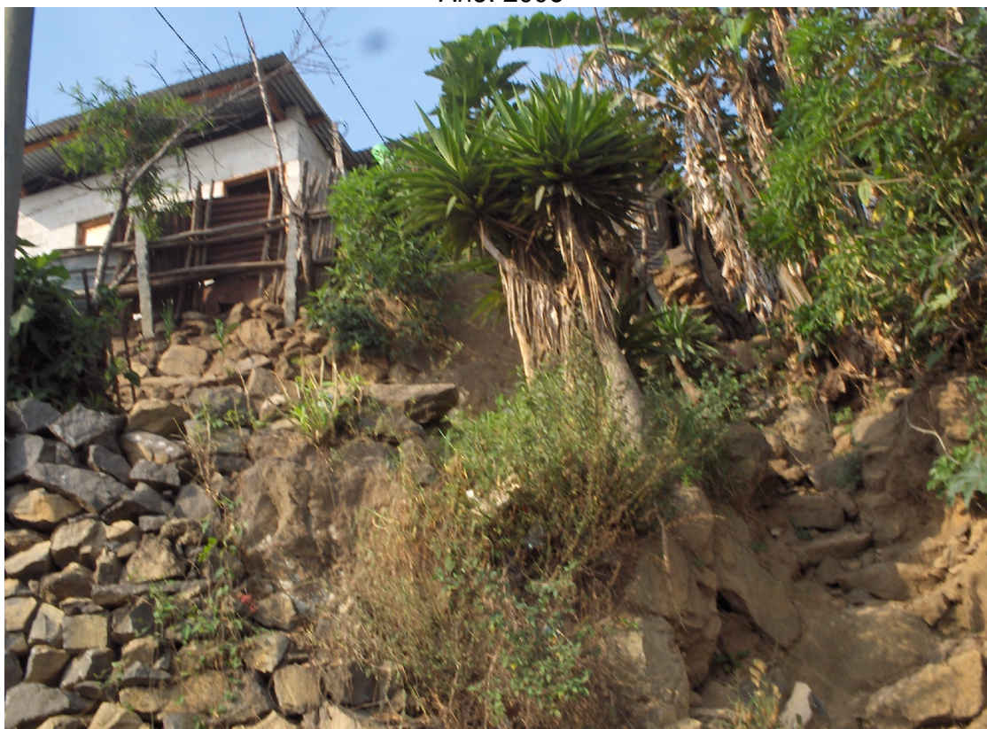
Foto 7 Municipio de San Pedro La Laguna - Sololá Fotos de Riesgos del Municipio Año: 2006
