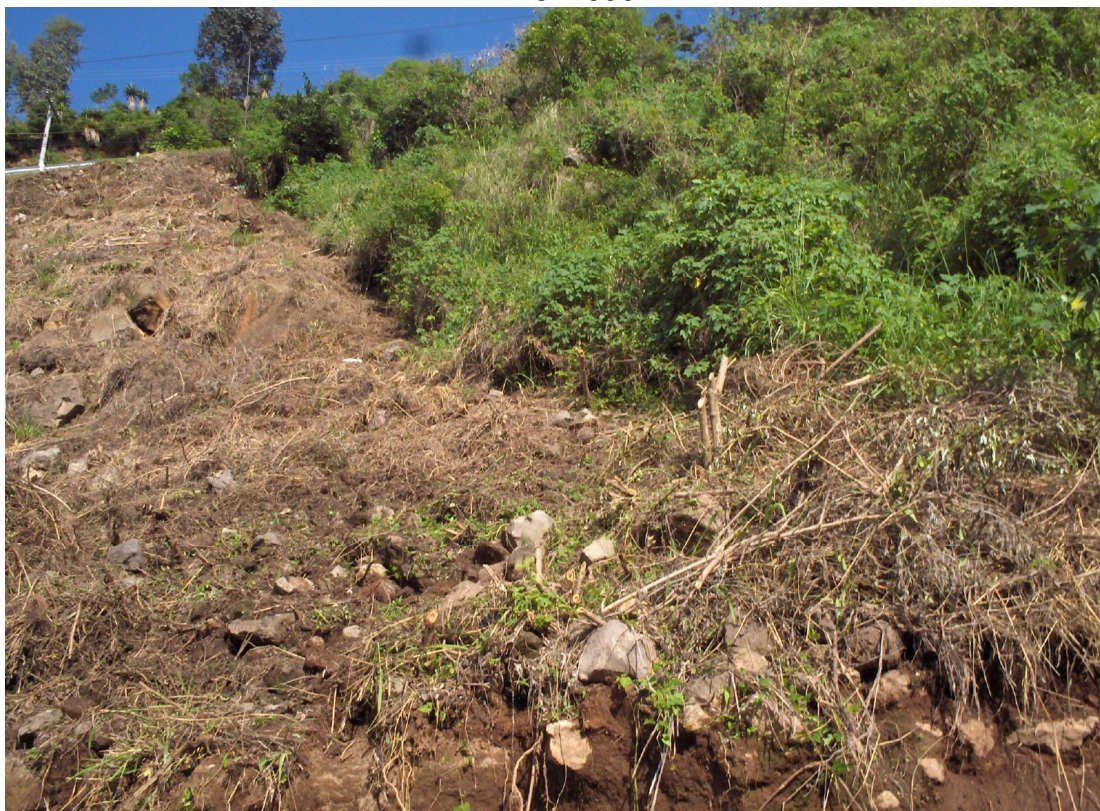
Foto 1 Municipio de San Pedro La Laguna - Sololá Fotos de Riesgos del Municipio Año: 2006
