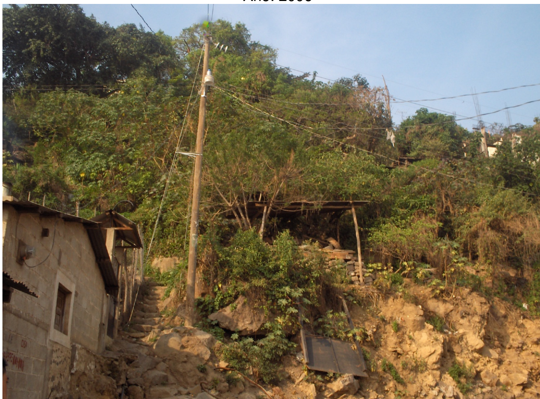
Foto 5 Municipio de San Pedro La Laguna - Sololá Fotos de Riesgos del Municipio Año: 2006
