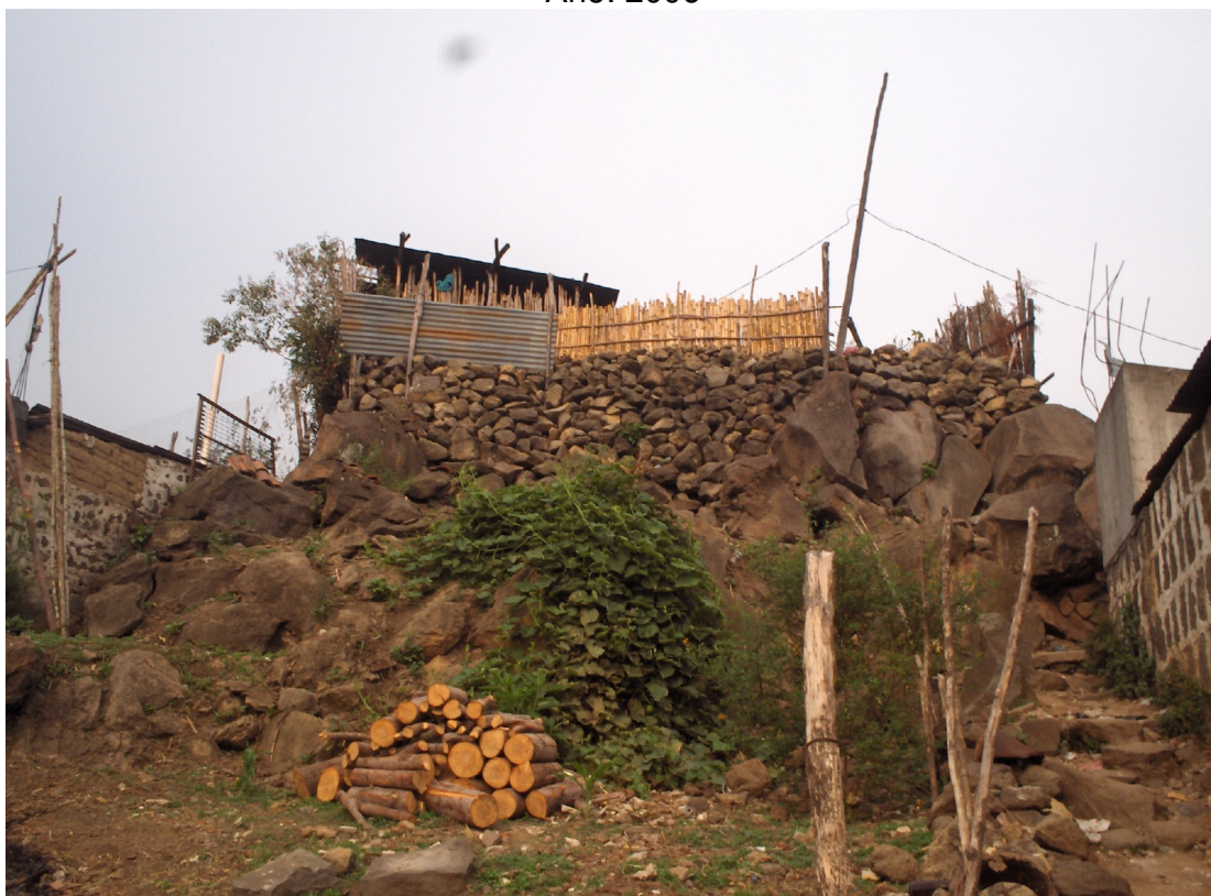
Foto 4 Municipio de San Pedro La Laguna - Sololá Fotos de Riesgos del Municipio Año: 2006
