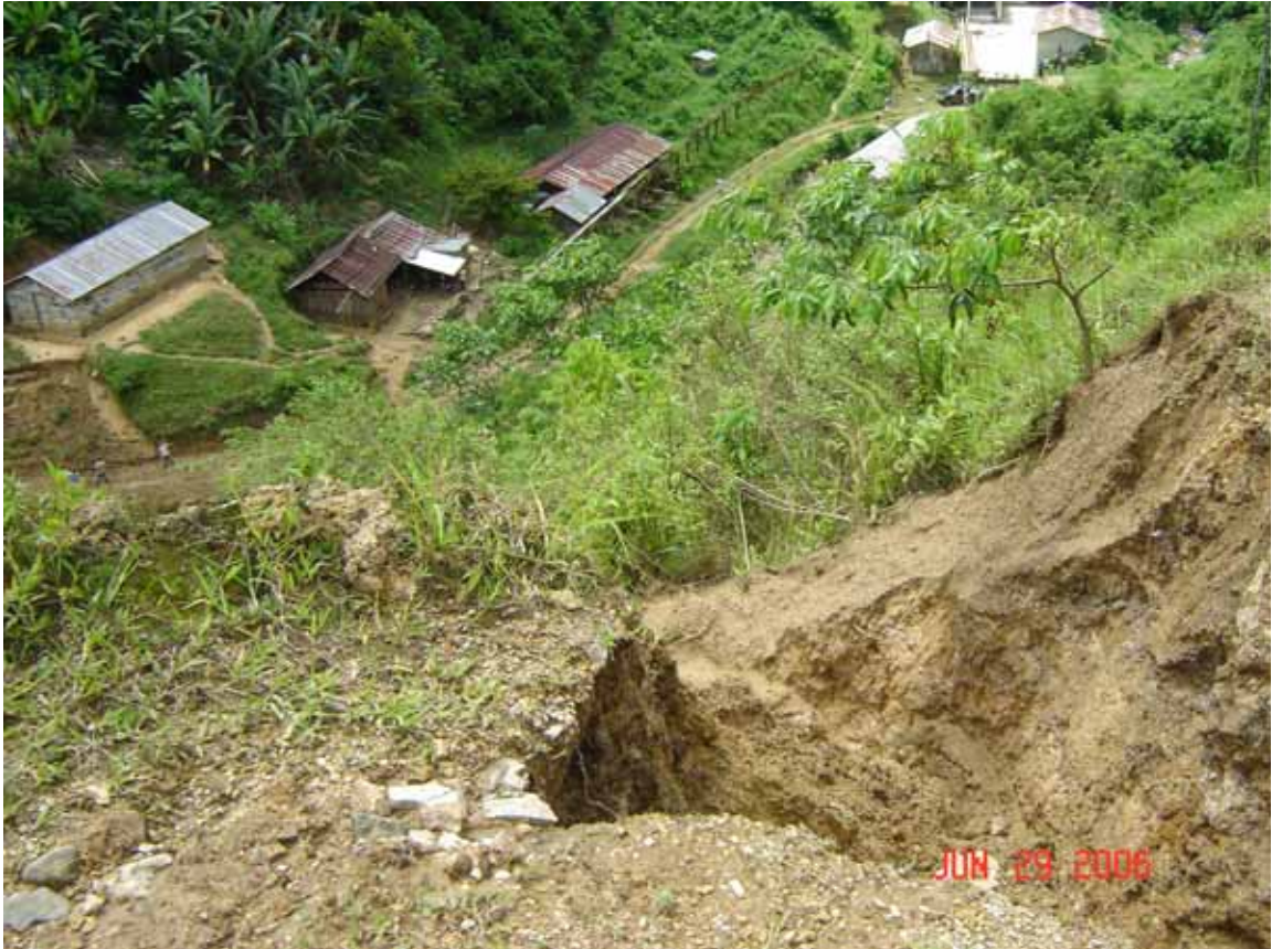
Foto 7 Municipio de Gualán – Zacapa Derrumbe en Finca La Cartuchera Año: 2006
