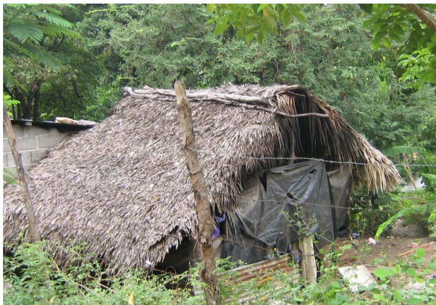
Fotografía 1 Municipio de Teculután - Departamento de Zacapa Vivienda en Riesgo de Derrumbe Caserío El Oreganal Año: 2006
