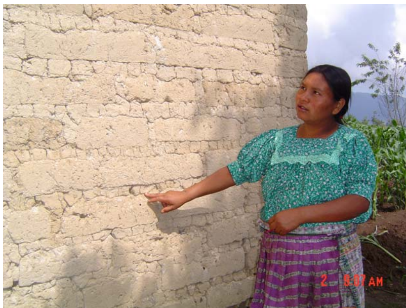
Fotografía 1 San José Chacayá - Sololá Caserío Villa Linda Paso de la tormenta Stan, daños a viviendas Año 2006
