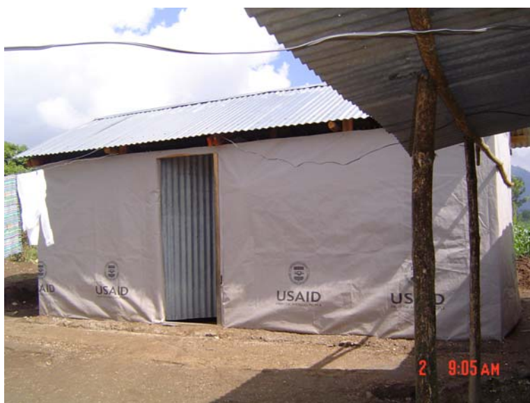
Fotografía 3 San José Chacayá - Sololá Caserío Villa Linda Paso de la tormenta Stan, reconstrucción de viviendas Año 2006
