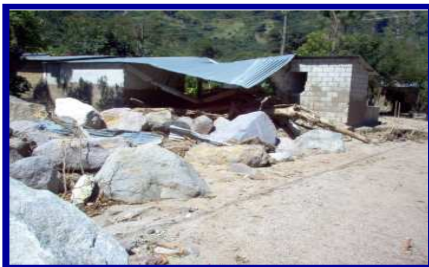
Fotografía grupo EPS, junio 2006. Escombros colonia cinco de Enero.
