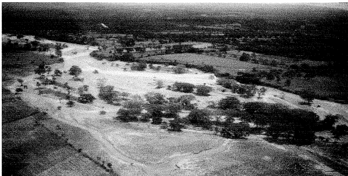
Figura 14 Municipio de Estandzuela - Departamento de Zacapa Daños causados por el Huracán Mitch Año: 2006
