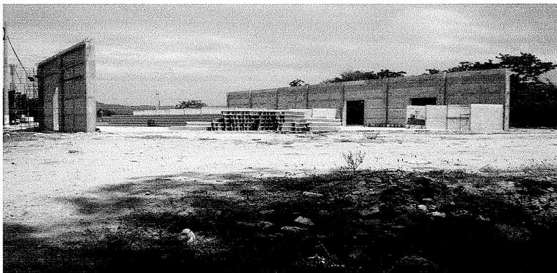
Figura 19 Municipio de Estanzuela - Departamento de Zacapa Edificio en Construcción Año: 2006
