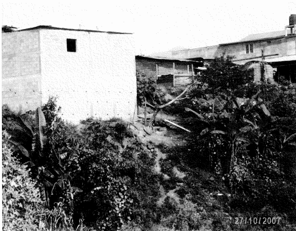
Imagen 12 Municipio de Joyabaj, Departamento de Quiché Viviendas propensas a derrumbe, Barrio La Democracia Año: 2007
