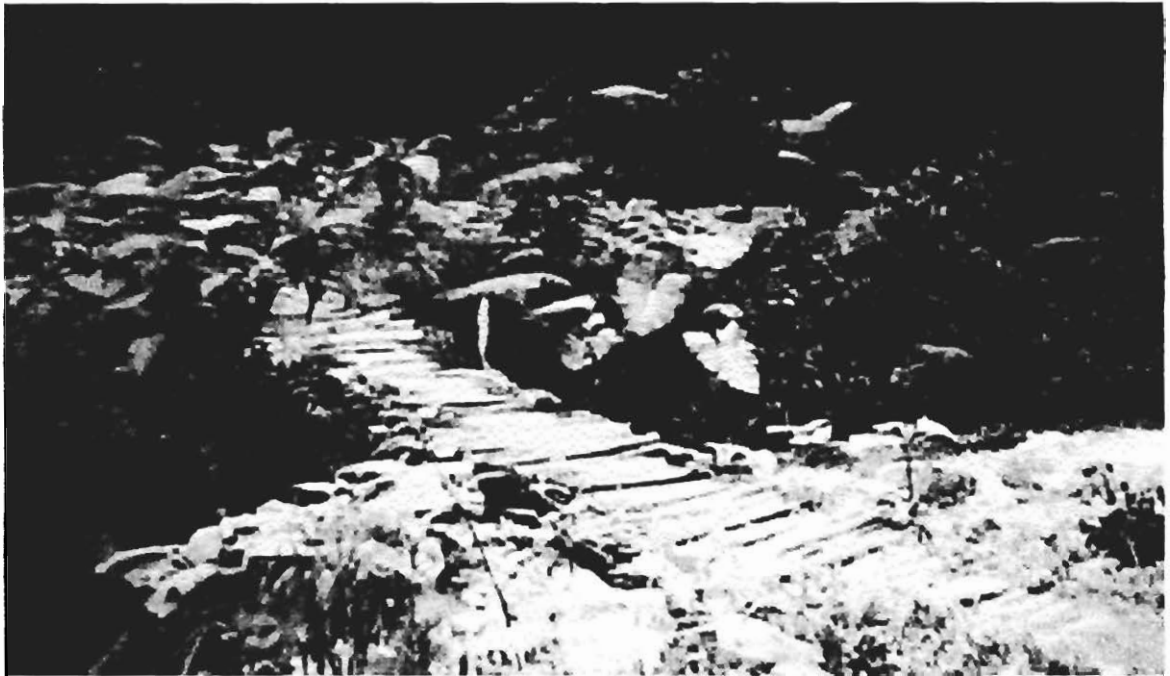
Puente peligroso, municipio de San Pablo Tamahú.
