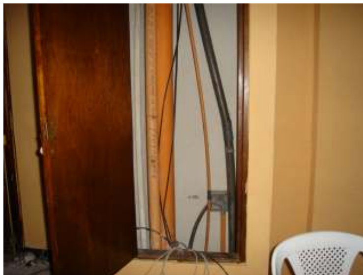
Imagen 1 Conductos de alumbrado y agua potable
