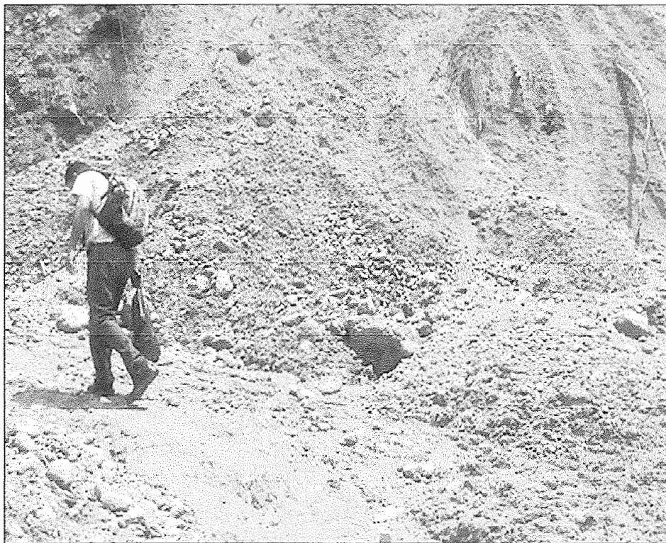
Fotografía. No. 2 Derrumbe de Parramos Grande-Nebaj, Quiché. Año: 2008.
