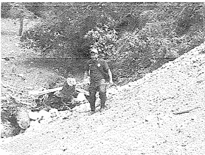
Derrumbe de Parramos
