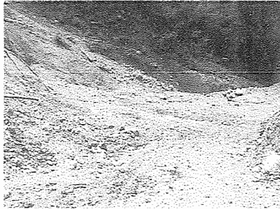
Derrumbe de Parramos Grande
