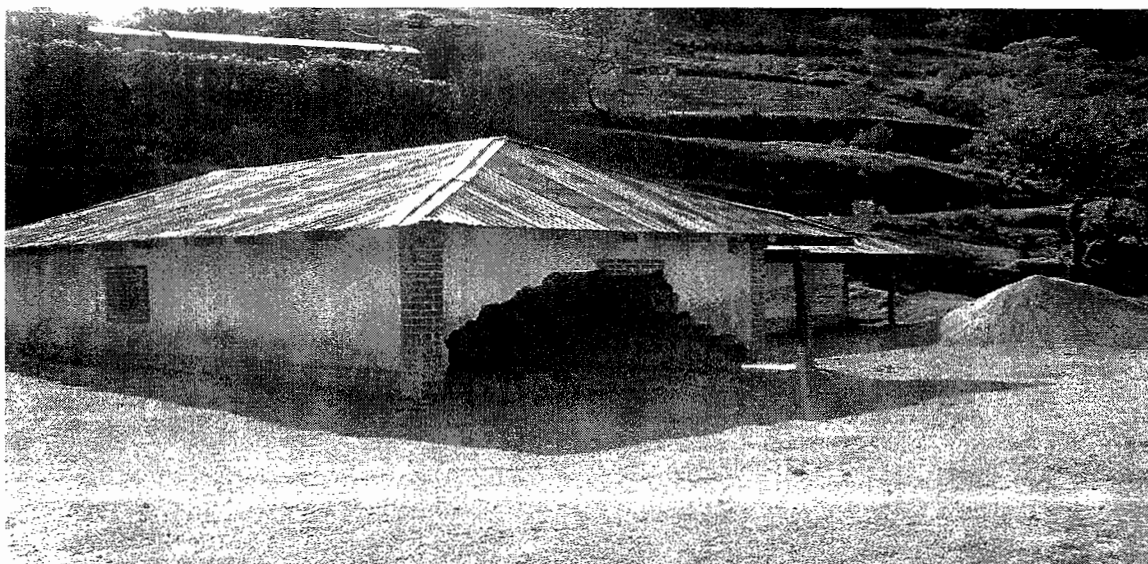
Fotografía 9 San Antonio Sacatepéquez – San Marcos Construcciones colapsables, aldea Santo Domingo Año: 2009
