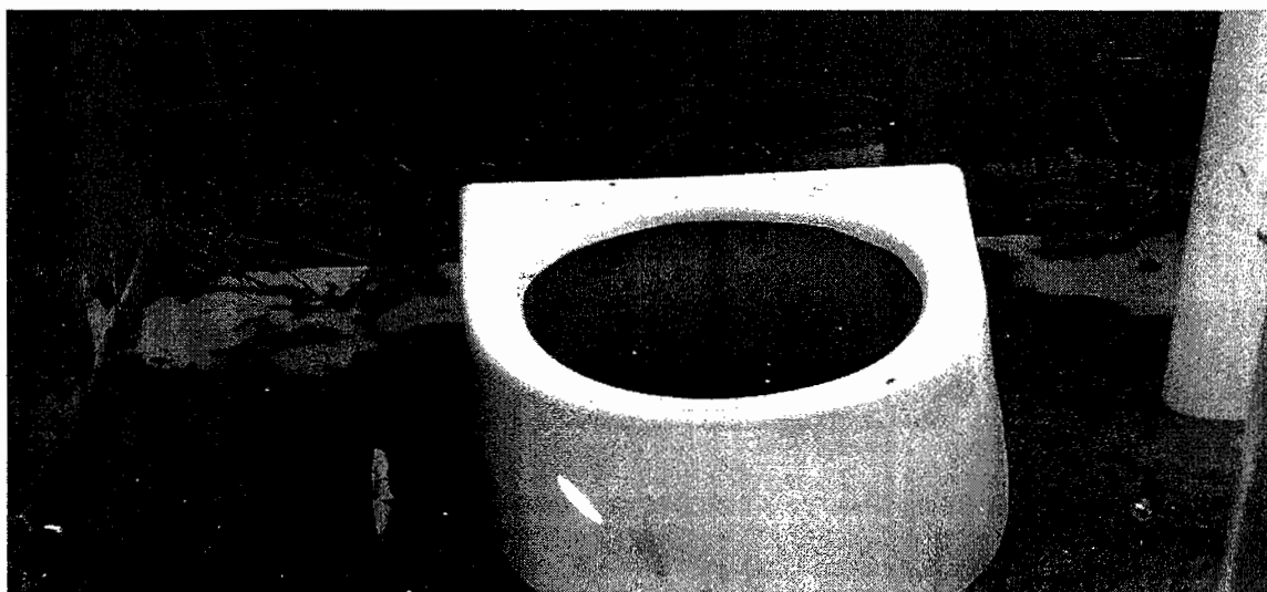
Fotografía 7 Municipio de San Antonio Sacatepéquez – San Marcos Contaminación ambiental por letrinas deterioradas Año: 2009
