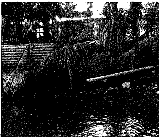
Riesgo antrópico por construcción de edificaciones en ́rea de riesgo.
