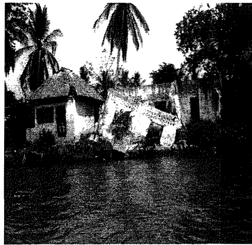
Vivienda dañada por desbordamiento de río Naranjo.
