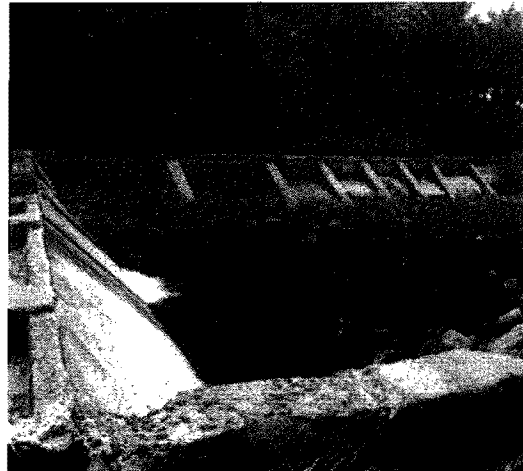
Presa construida en el río Mopá, para desvío de caudal hacia plantaciones, provoca desbordamiento en época de lluvia.
