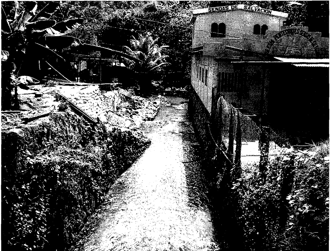
Imagen 6 Municipio de Chicacao, Departamento de Suchitepéquez Construcción de Viviendas a Orillas de Brazo del Río Cutzán Año: 2010
