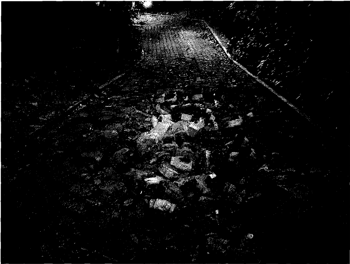
Imagen 7 Municipio de Chicacao, Departamento de Suchitepéquez Hundimiento de Calle en Aldea San Pedro Cutzán Año: 2010
