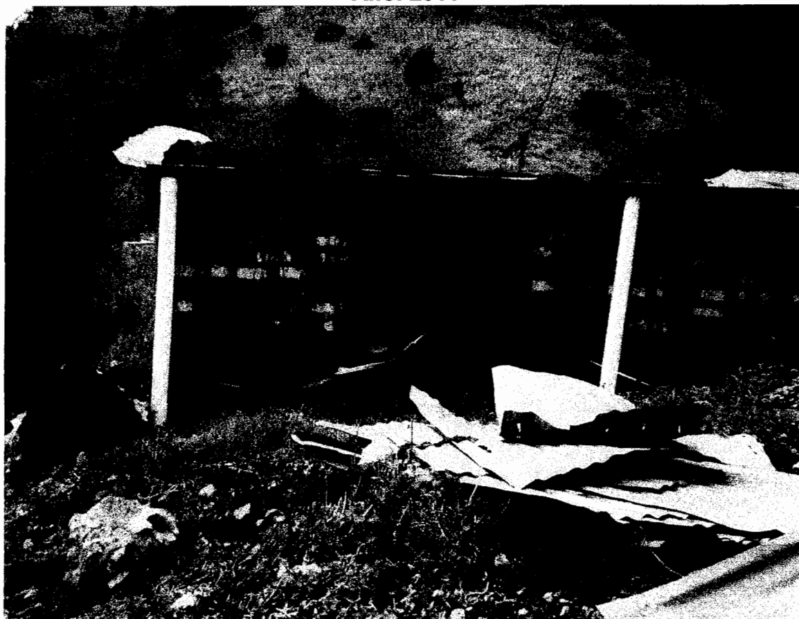
Fotografía 3 Municipio de Yupiltepeque, Departamento de Jutiapa Desprendimiento de Lamina por Fuertes Vientos Aldea El Llano Año: 2011
