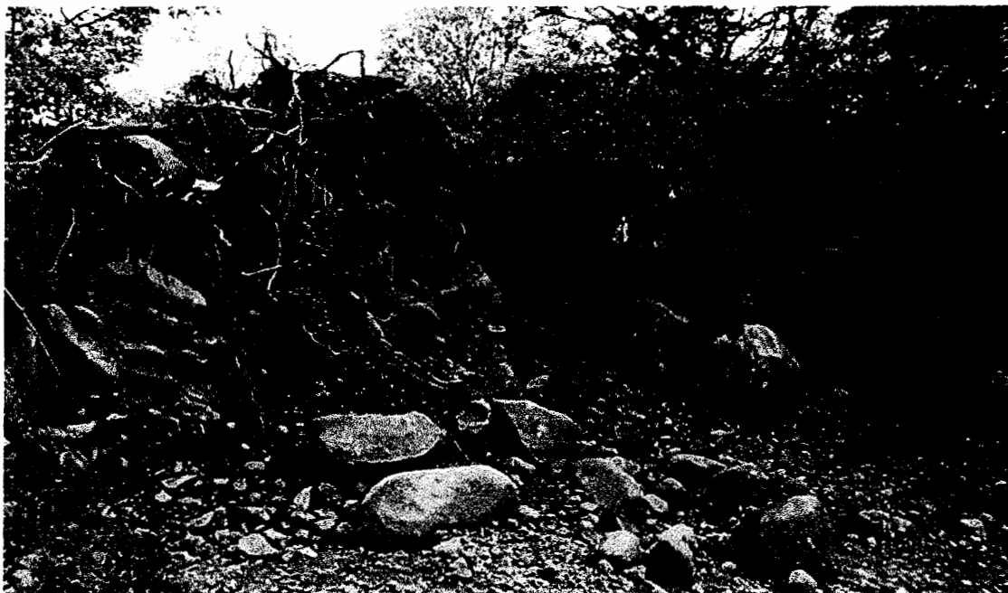
Foto 3 Municipio de Conguaco, Departamento de Jutiapa Derrumbe, caserío Buenos Aires Año 2011
