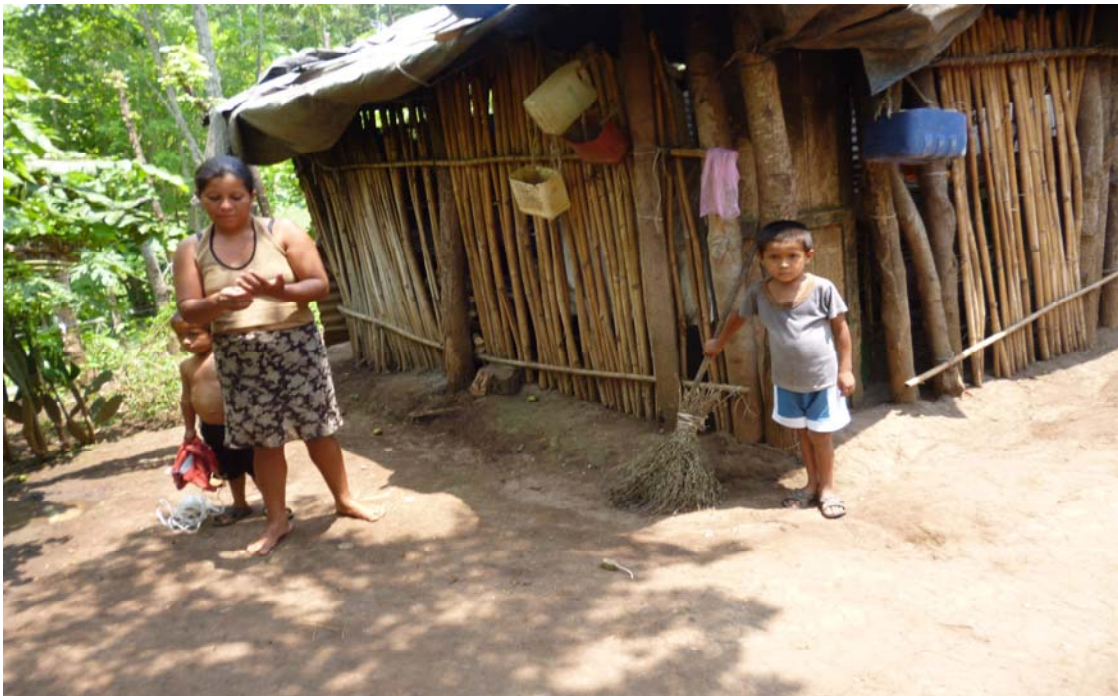
Fotografía 12 Municipio de Tiquisate, departamento de Escuintla Vivienda construida con caña, Parcelamiento el Arisco
