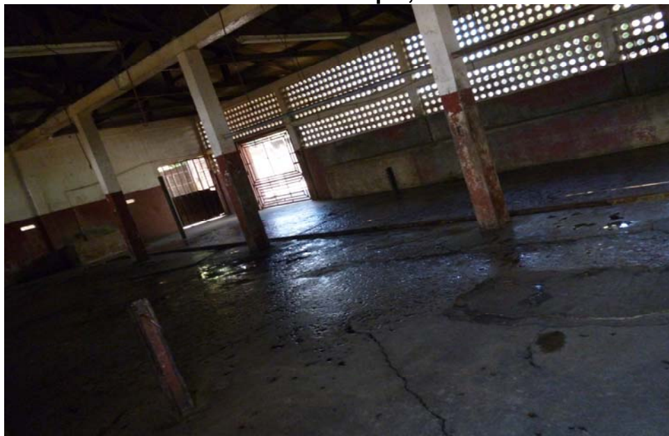
Fotografía 16 Municipio de Tiquisate, departamento Interior del rastro municipal, casco urbano
