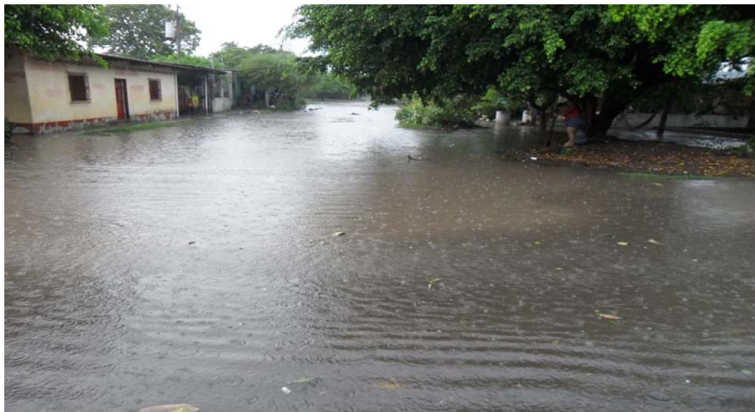
Fotografía 4 Municipio de Tiquisate, departamento de Escuintla Inundaciones, por falta de drenajes en el casco urbano
