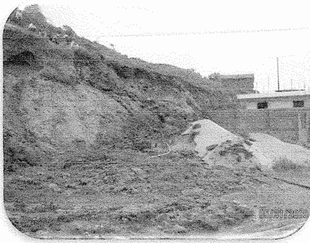
Figura 4. Vivienda ubicada en un punto de riesgo por derrumbe
