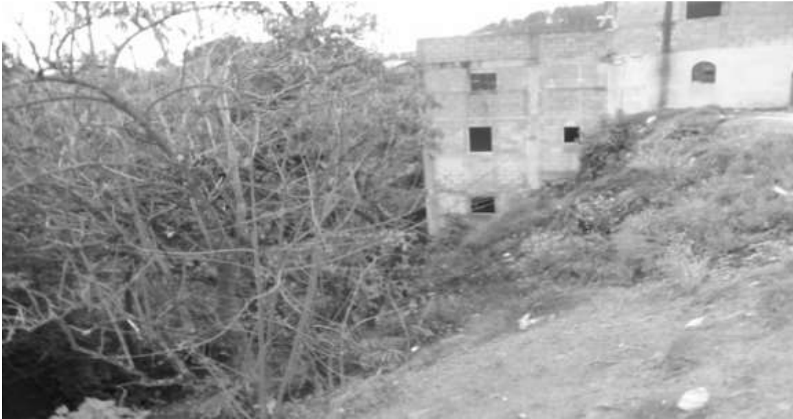
Fotografía 5 Vivienda en zona de riesgo
