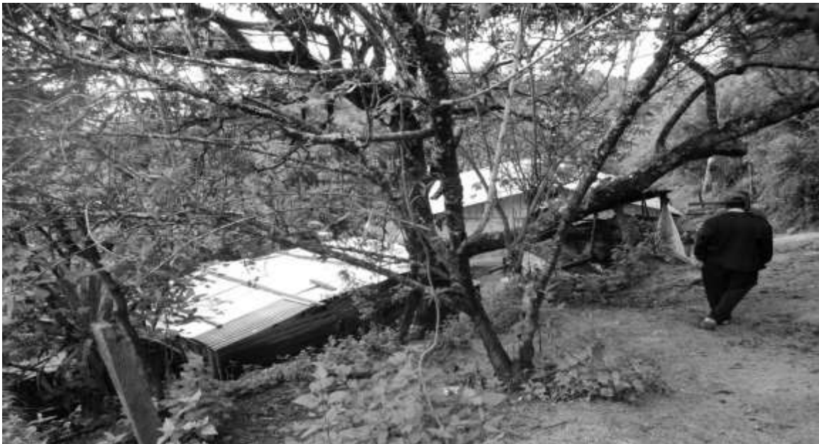
Fotografía 4 Vivienda en zona de riesgo
