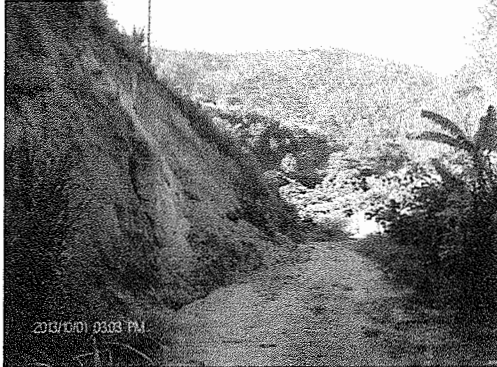
Derrumbes en las vías de acceso
