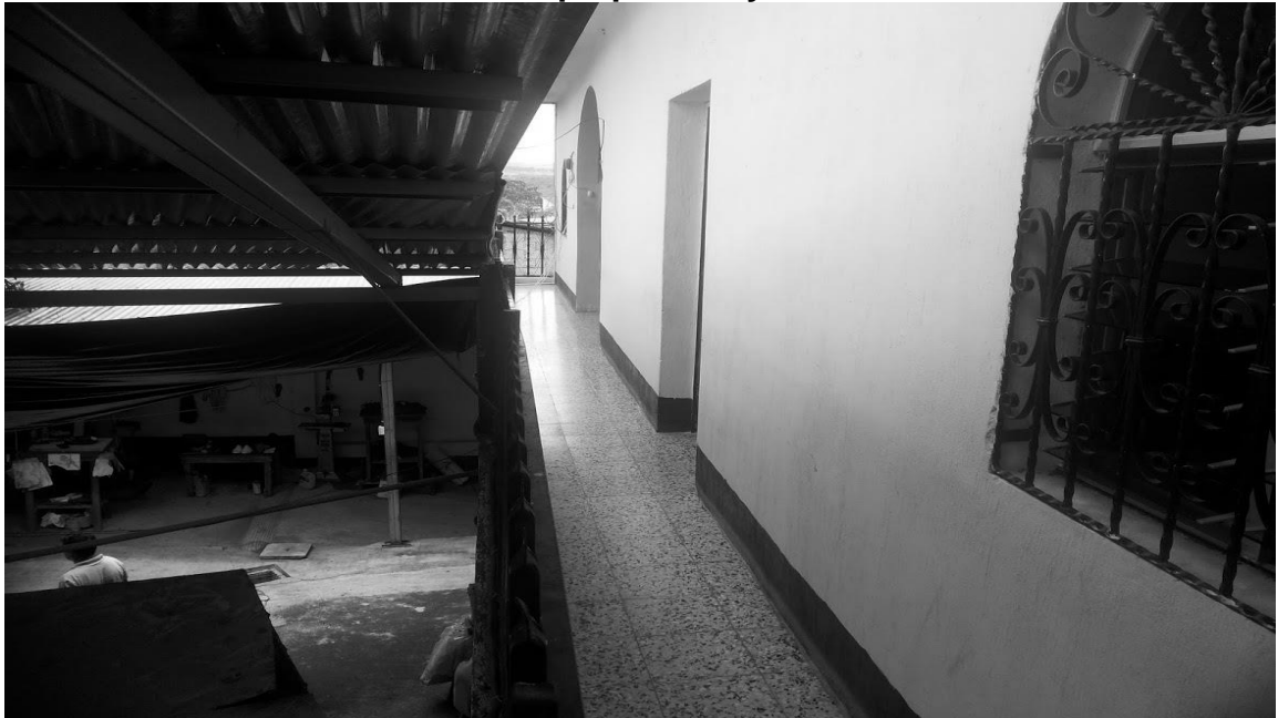
Figura 17 “INDUSTRIA Y COMERCIALIZADORA “K´TOCALZA” Vista desde la planta alta a planta baja e ingreso a área de empaquetado y oficinas
