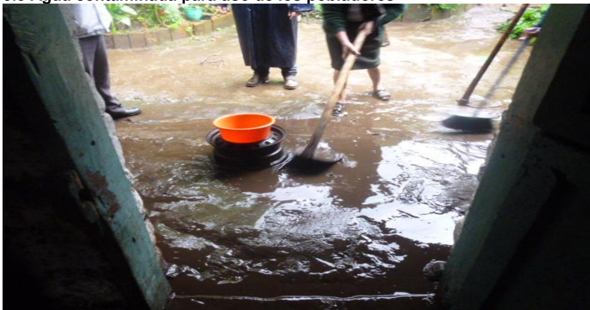
3.6 Inundación en vivienda
