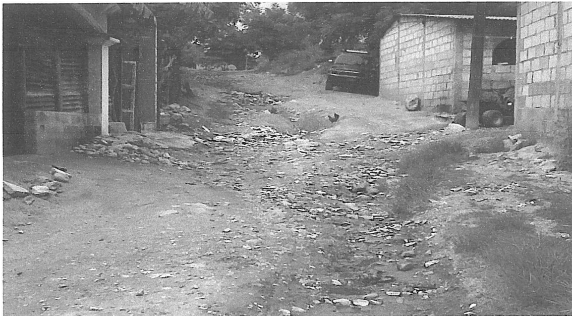
Foto 7 Contaminación ambiental por falta de drenajes.
