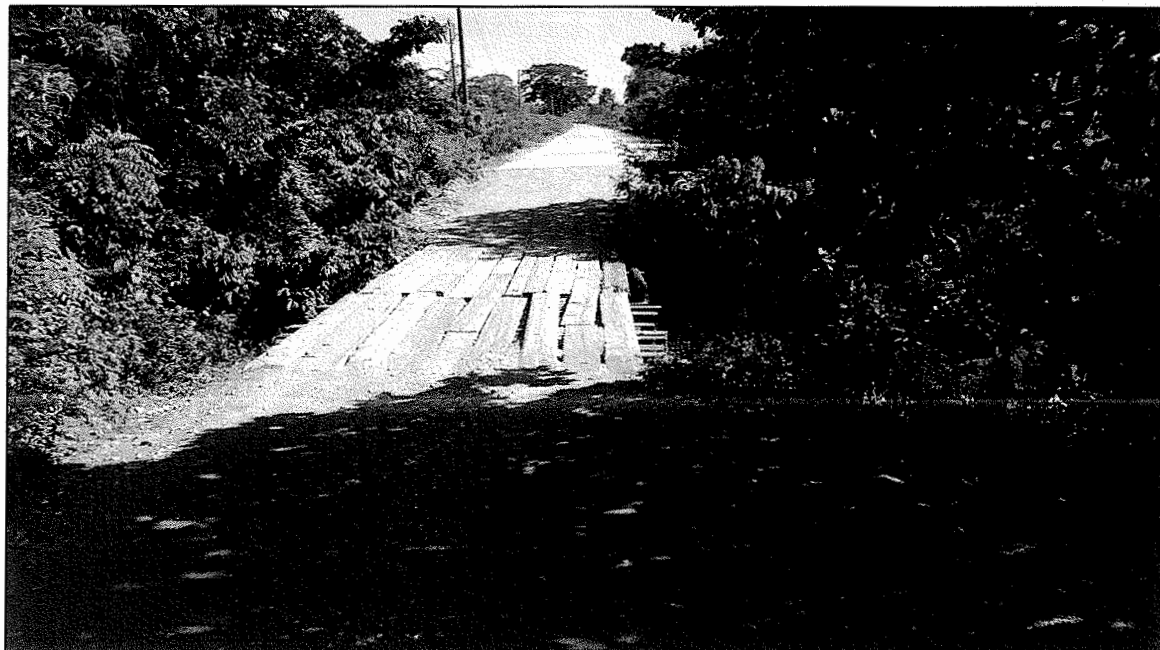
FOTO 2 Municipio de Morales, Departamento de Izabal Puentes en mal estado
