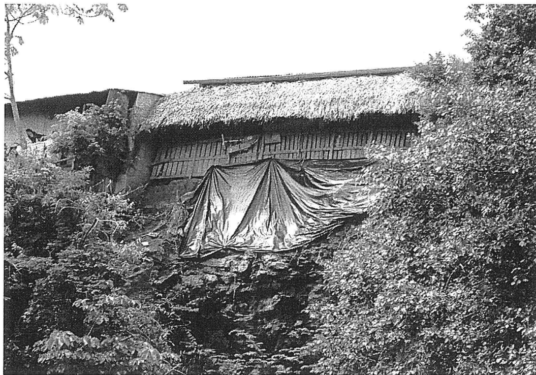
Fotografía 1 Municipio de Teculután, Departamento de Zacapa Vivienda en riesgo de derrumbe Caserío Barranco Colorado Año: 2014
