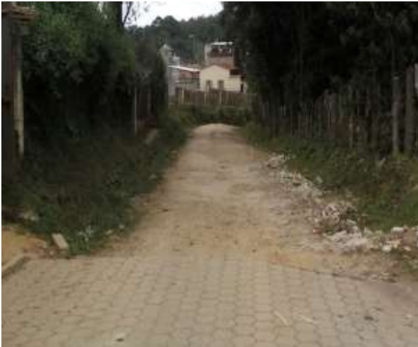
Final del adoquinamiento calle principal, frente a la escuela Aldea Agua Dulce
