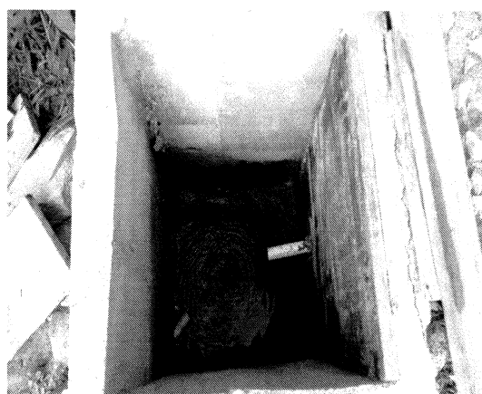
Nacimiento de agua no aprovechado a la fecha
