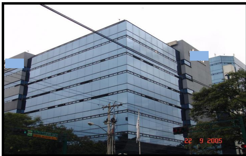
FIGURA 3. Edificio de la sede central de la entidad de gobierno.
