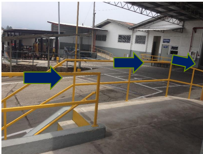
Figura 18, señalización en garita 5 (ruta Toki)
