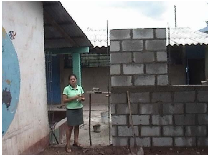
Fundición de columnas
