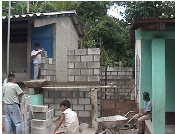
Fundición de solera intermedia y levantado de muros.
