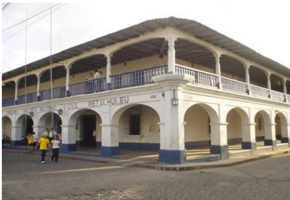
Edificio de la Policía Nacional Civil Retalhuleu
