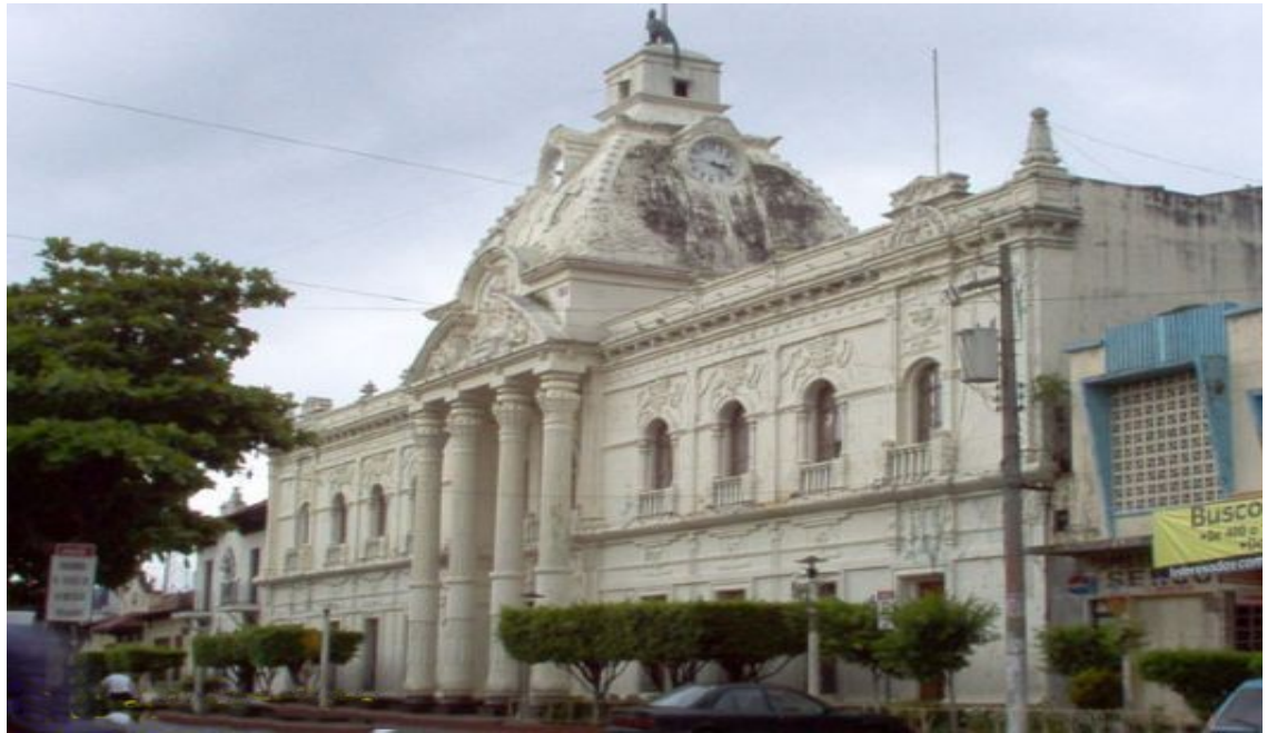
PALACIO DEPARTAMENTAL DONDE FUNCIONA LA MUNICIPALIDAD DE RETALHULEU (AGOSTO 24- 2006)
