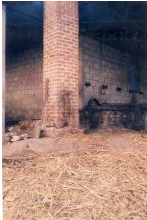
Chimenea donde sale parte de los desechos de la caña de azúcar (bagazo).
