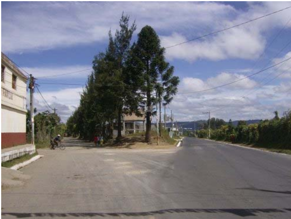
CARRETERAS PRINCIPALES QUE CONDUCEN A CHIMALTENANGO LADO IZQUIERDO: CARRETERA VIEJA. LADO DERECHO CARRETERA NUEVA
