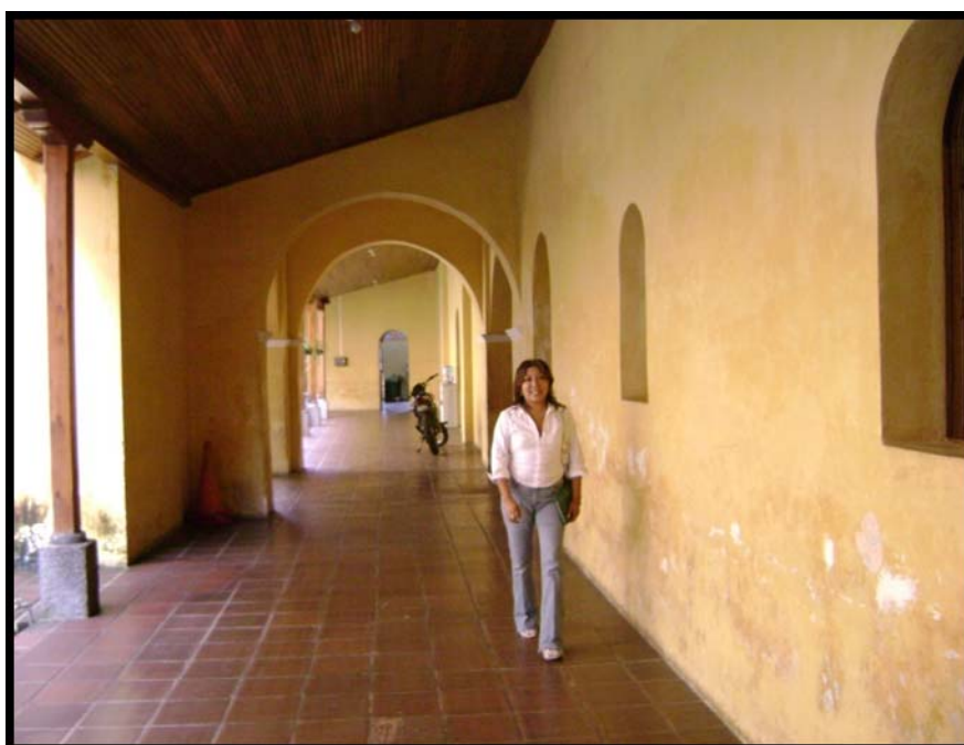
Fotografías que nos muestran una vista externa e interna del edificio Municipal de Patulul.
