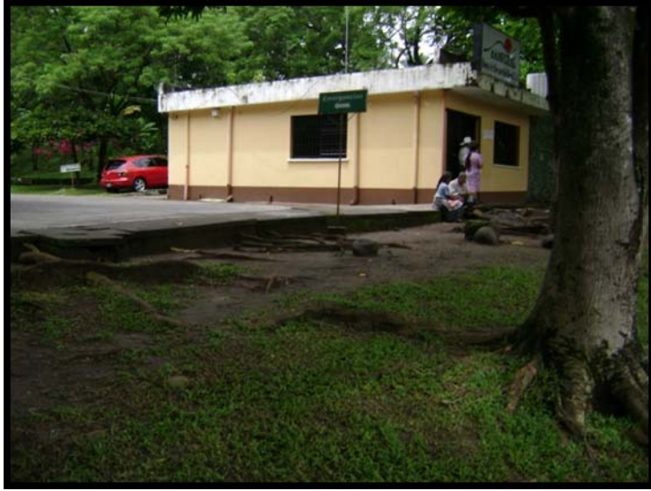
Banrural destinado para el pago de los pensionados del IGSS
