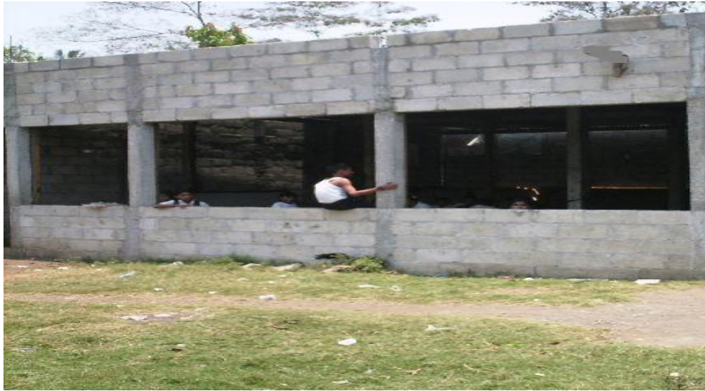
Proceso de construcción de dos aulas en el Instituto Municipal de Educación Básica (IMEB) del Parcelamiento Santa Isabel, Puerto San José, Escuintla.
