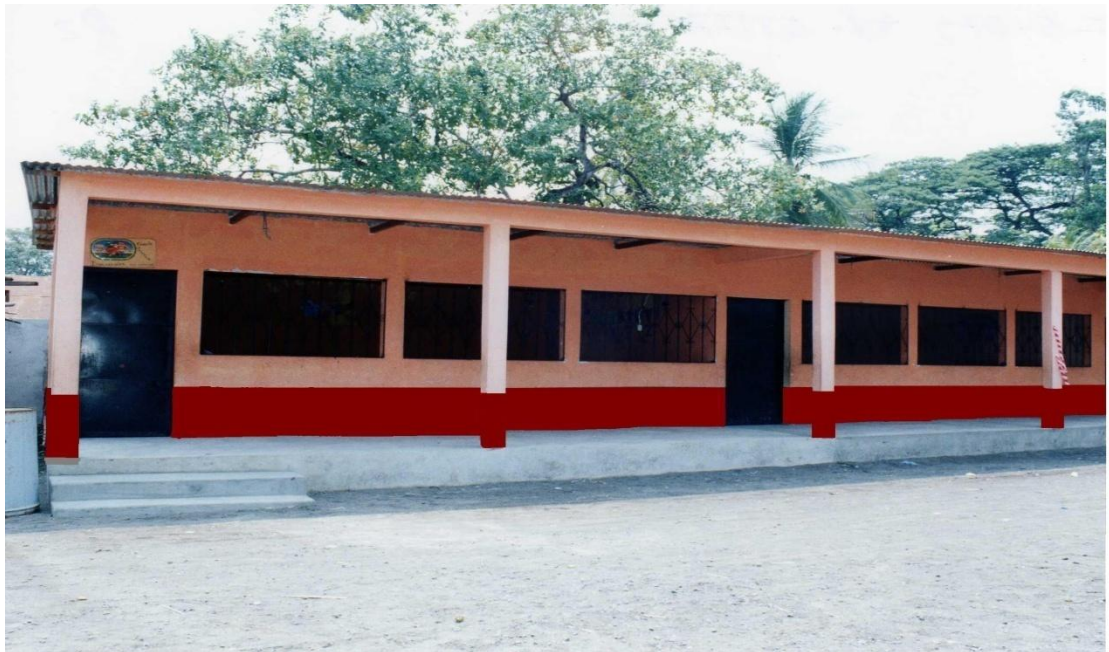
Culminación de la construcción de dos aulas al servicio de los estudiantes de básico del Instituto Municipal de Educación Básica (IMEB) del Parcelamiento Santa Isabel, Puerto San José, Escuintla.
