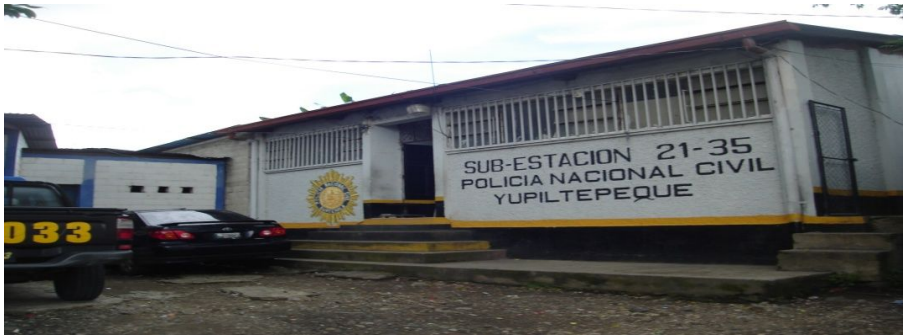
■Subestacion de la PNC, ubicada al Nororiente del Edificio Municipal
