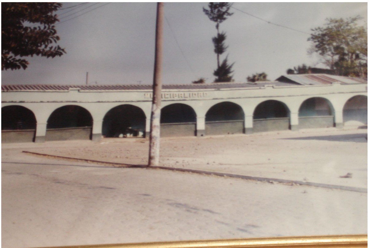
◀ Edificio antiguo de la Municipalidad de Yupiltepeque.
