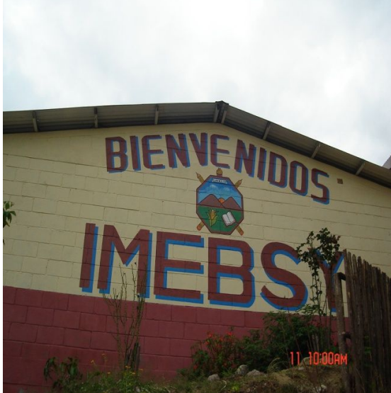
◀ Edificio del Instituto de Educación Básica por Cooperativa, cabecera municipal
