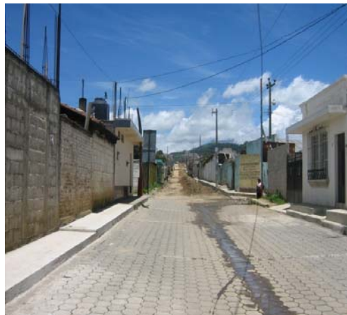
CALLE EN REPARACIÓN
