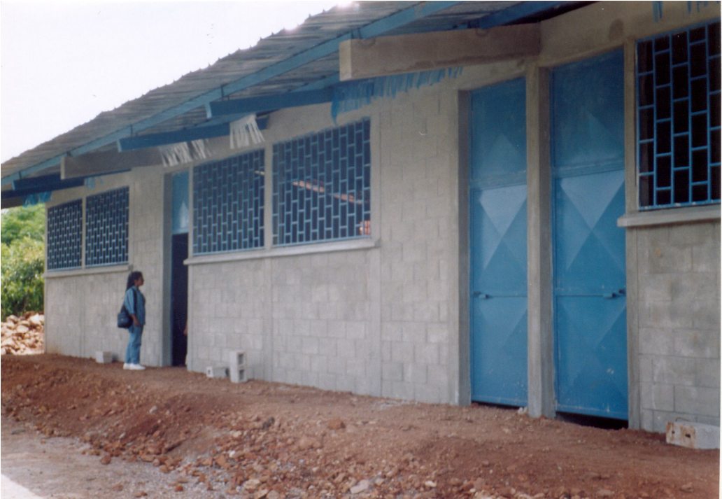
Construcción de dos aulas en su fase intermedia
