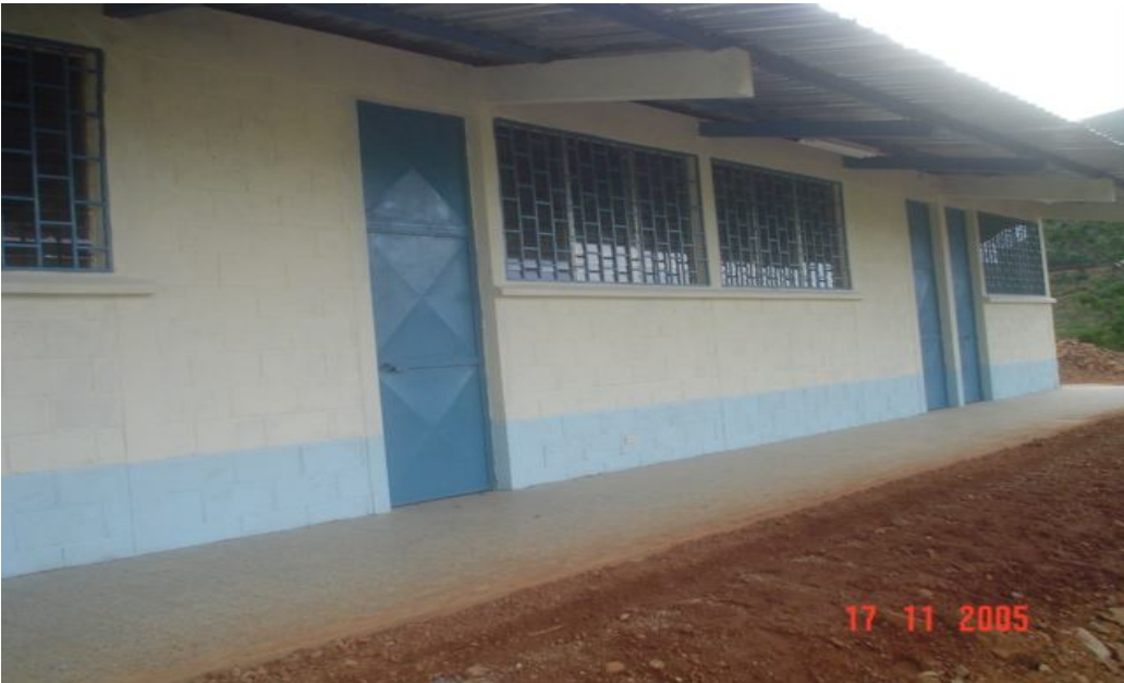
Culminación de las dos aulas
