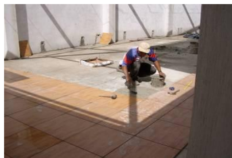
Fig. 19 Colocando piso en el salón de biblioteca Foto: Bib. Dora María Cardoza
