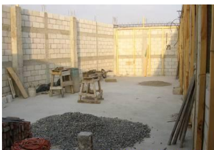
Fig. 16 Construcción del salón de biblioteca Foto: Bib. Dora María Cardoza
