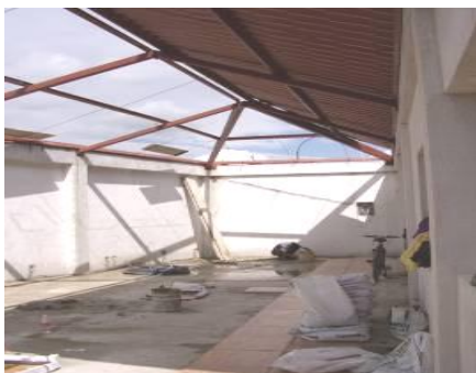
Fig. 20 Colocando techo en el salón de biblioteca Foto: Bib. Dora María Cardoza
