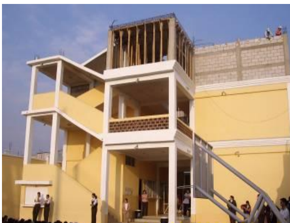
Fig. 13 Vista frontal del edificio Foto: Bib. Dora María Cardoza
