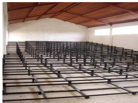
Fig. 21 Construcción del salón de Audiovisuales Foto: Bib. Dora María Cardoza
