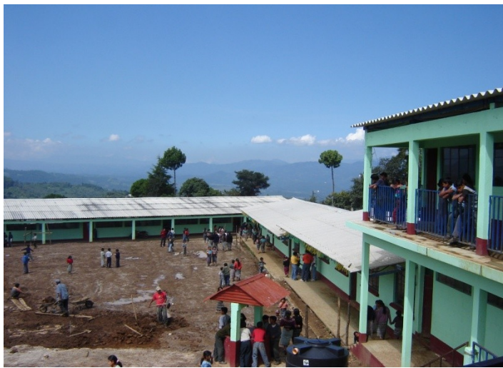
E.O.R.M. El Pilar I, aquí pueden observarse los trabajos para la construcción de cancha polideportiva.
