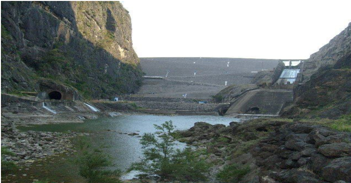
Represa en hidroeléctrica del Río Chixoy, Baja Verapaz, Guatemala.
