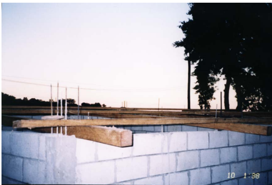
Fig. 3 Vista Panorámica de la instalación del techo
