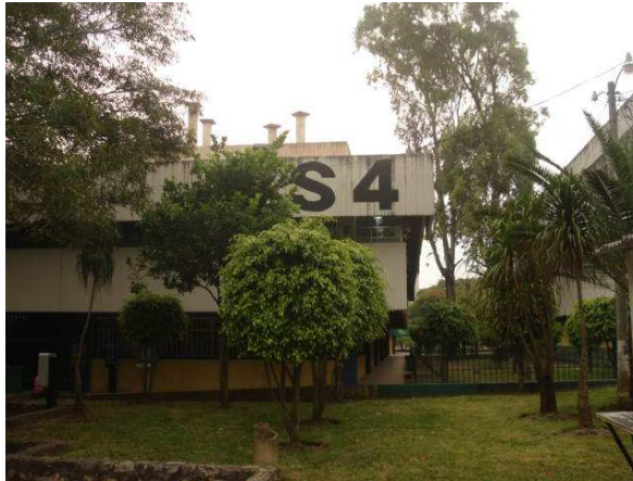
Foto 1. Vista exterior del edificio S-4, Facultad de Humanidades de la Universidad de San Carlos de Guatemala.
