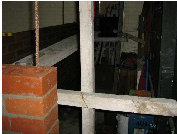
Foto 13. Refuerzo en columnas
