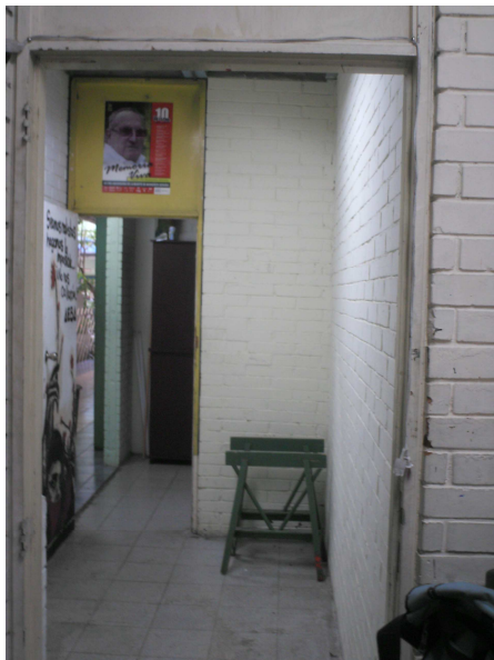
Foto 18. Corredor de ingreso a la AEBA
