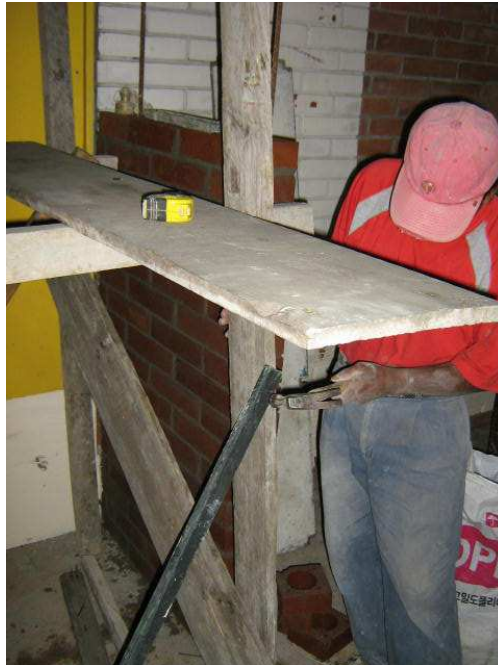
Foto 11. Medición y levantamiento de andamios
