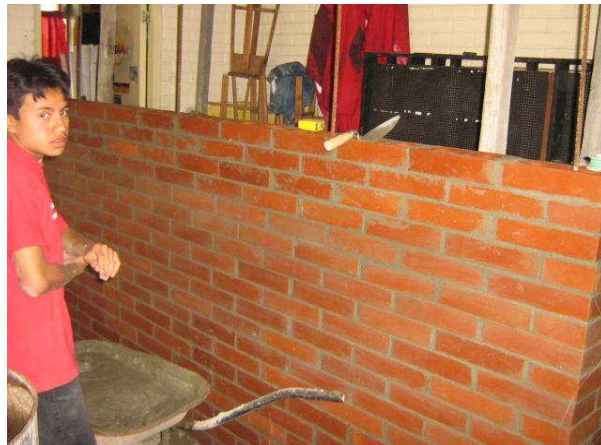
Foto 14. Levantamiento de muro de separación
