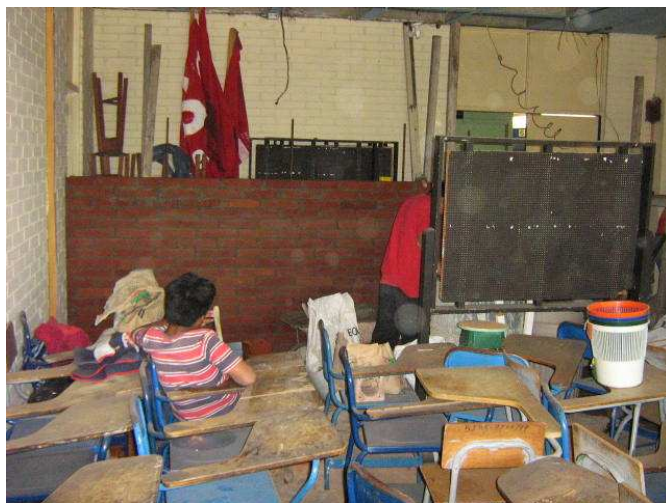
Foto 17. Levantamiento de muro de separación
