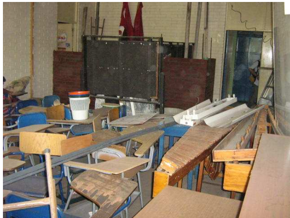
Foto 15. Vista interior del salón 107 durante los trabajos.
