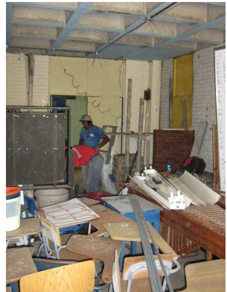
Foto 16. Instalación inmediata de conductos eléctricos.
