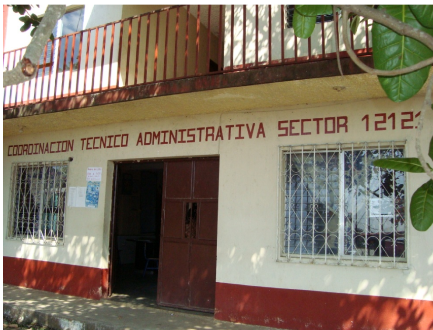
Edificio de la Coordinación Técnico Administrativa Sector 12.12.1, Nuevo Progreso, San Marcos
