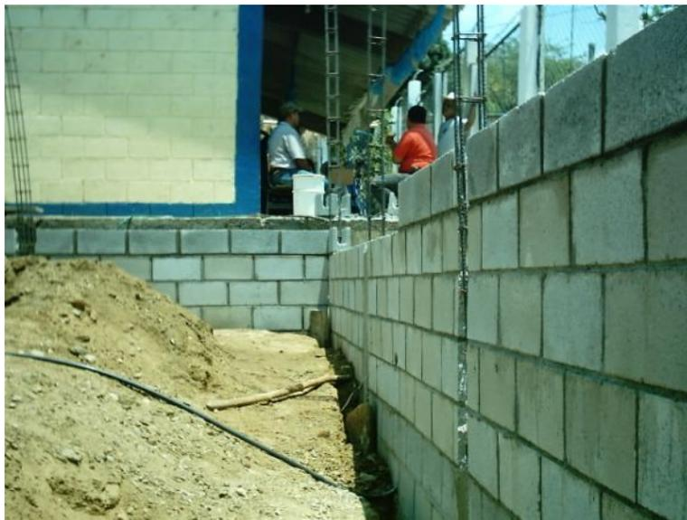
Fundición de cemento corrido, solera de humedad, levantado de hiladas de block para paredes y una hilada block tipo U para solera intermedia.
