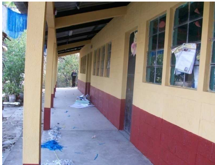
CORREDOR DE UNA DE LAS AULAS DE LA ESCUELA DE PACHALUM
