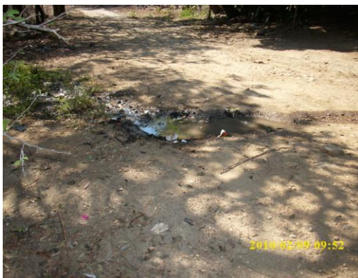
Desagües a flor de tierra
