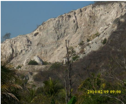
Deslizamientos de tierra
