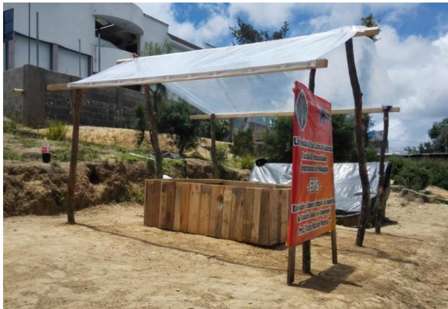
Fotografía No. 21 se puede apreciar el techo terminado, también se observa que esta de forma triangular y con nylon transparente, de esta manera se evitará que el agua de lluvia quede acumulada en el techo. La colocación del nylon se realizó con el apoyo de los estudiantes y de una persona adulta.
