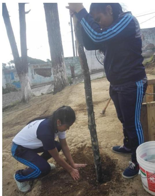
En las fotografías No. 19 y No. 20, se aprecia la participación de estudiantes en la construcción del techo, perforando seis agujeros para luego ir colocando los parales que sostendrán el techo.
