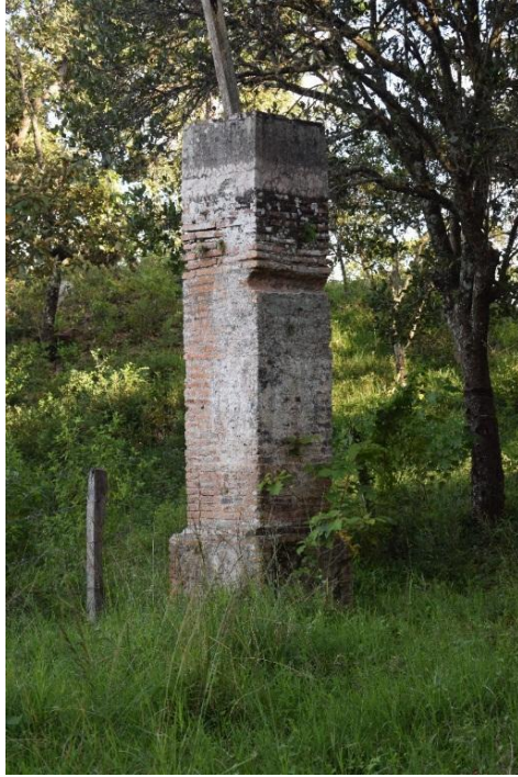
Imagen No. 14 Tercera caja de agua, una de las estructuras más altas (Agustin 2018)
