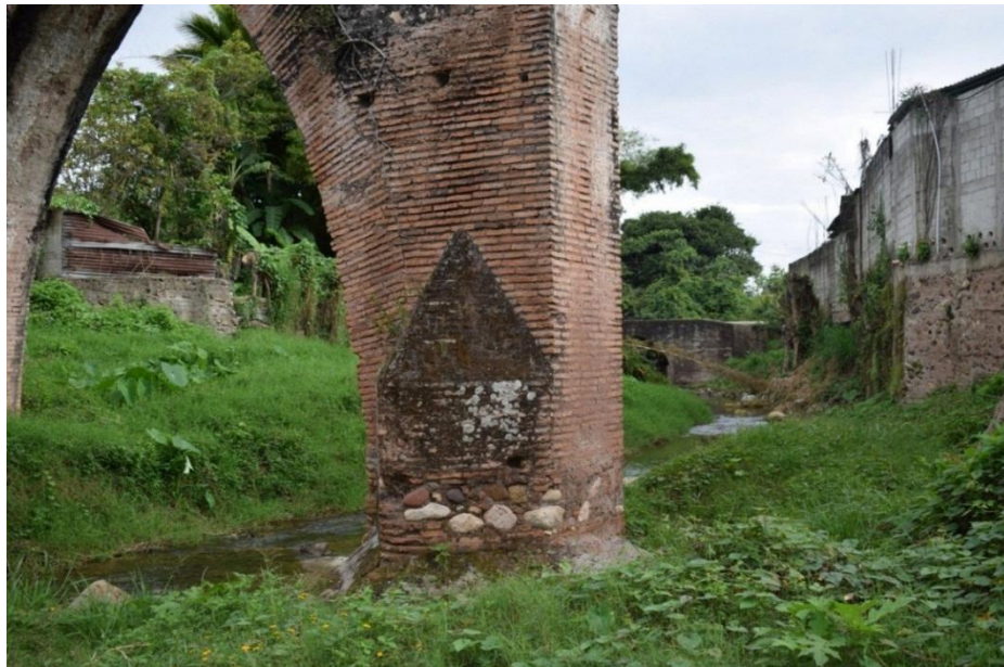
Imagen No. 28, detalle del tajamar en la base del arco, en la parte occidental de la segunda arquería (Agustin 2018 )
