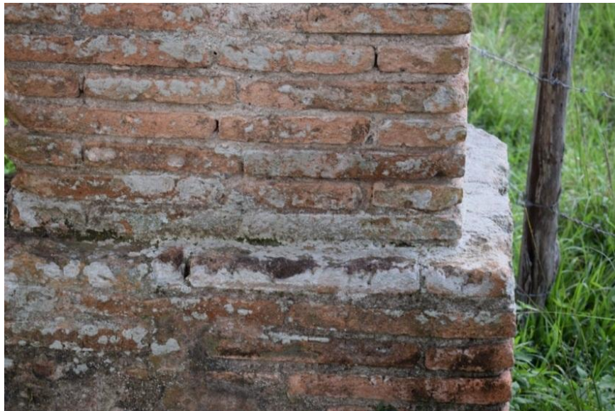
Imagen No. 16, Detalle inferior de la tercera caja de agua, las áreas blancas son restos de repello original (Agustin 2018 )
