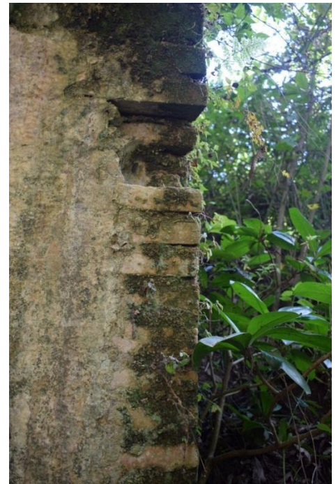
Imagen No. 11, Detalle del arco central de la primera arquería (Agustin 2018 )
