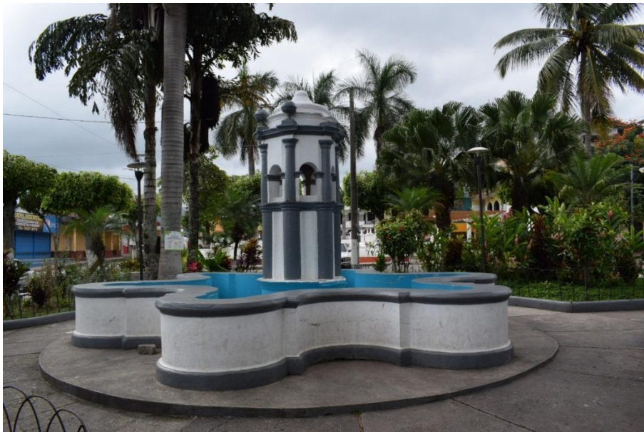
Imagen No. 39, Vista del la cara sur de la pila de distribución (Agustin 2018 )
