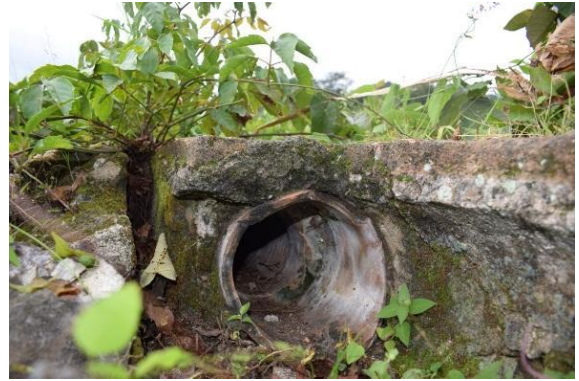
Imágenes No.31 y 32, Tubería de terracota sobre la segunda arquería (Agustin 2018 )
