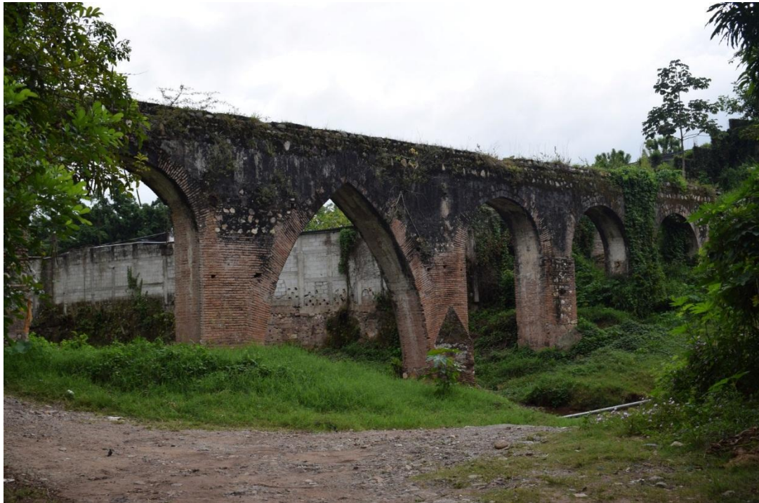
Imagen No. 29, Cara occidental de la parte más alta de la segunda arquería, se aprecia el detalle singular del arco ojival (Agustin 2018 )
