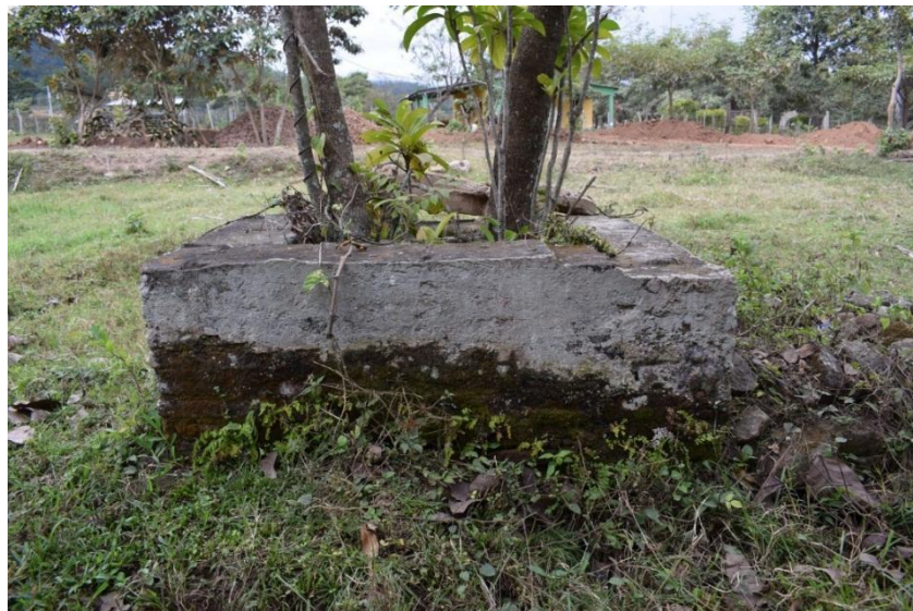
Imagen No. 20, Cara occidental de la quinta caja de agua (Agustin 2018 )
