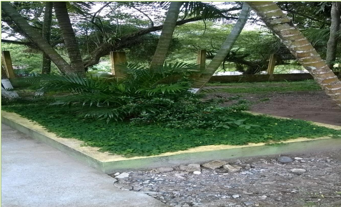
Área verde que necesita remozamiento en pintura.
